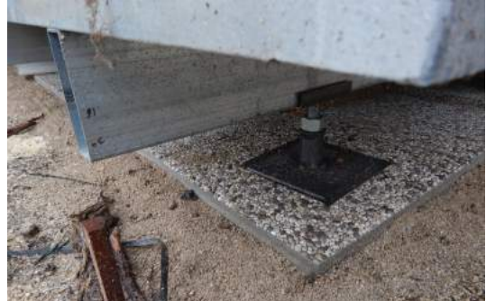
particolare del telaio montato in opera, completo di piedino, per imposta pareti perimetrali casa mobile
