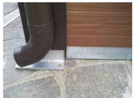
particolare del telaio montato in opera per imposta pareti perimetrali pannello sandwich
