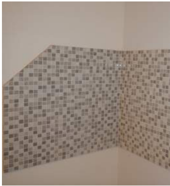
particolare rivestimenti in opera in grès ceramico
