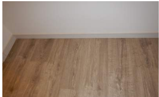
pavimento in laminato in opera
