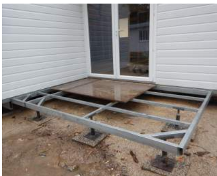
particolare del telaio montato in opera per imposta plateatico
