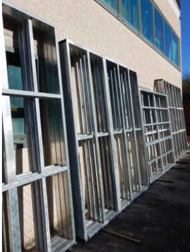
Telai in ferro tubolare zincato a caldo a misura, assemblati e saldati
